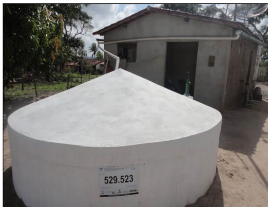
Figura 2 – Cisterna finalizada com instalação de encanamento para coletar a água chuva
