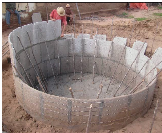
Figura 1 – Construção de cisterna
