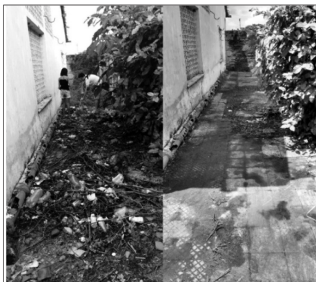
Foto 2 - Limpeza de resíduos sólidos e capinação dos locais
